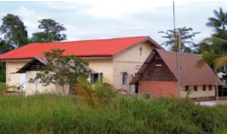
Het nieuwe gebouw met het kerkje op de achtergrond.
